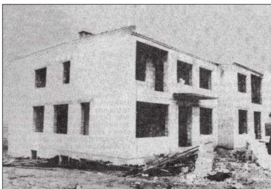
Apteka w trakcie budowy w 1987 roku.
